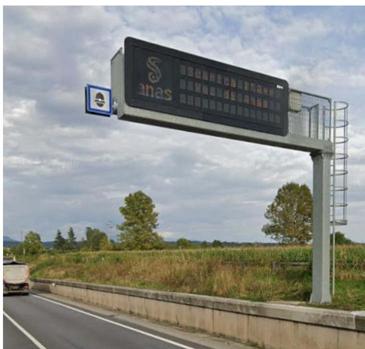
Figura 11 - Cartello sopra strumentazione direzione Salò
